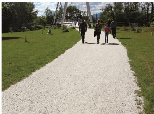
*Esempio di pavimentazione stradale in calcestre in progetto.*
