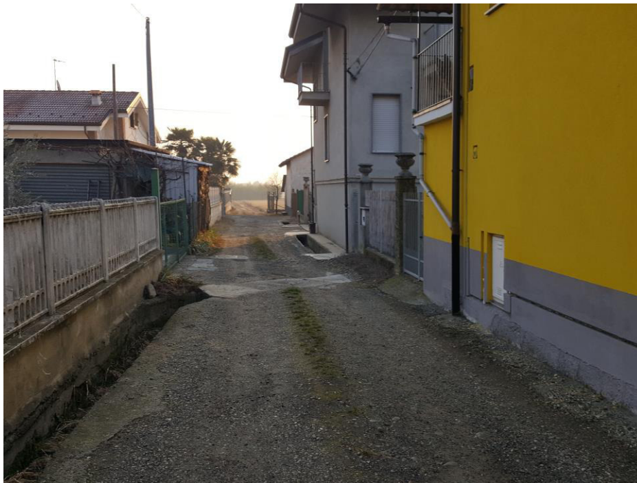
Fig.1 - Via Novara - attraversamento fosso irriguo sede stradale tratto intubato.
