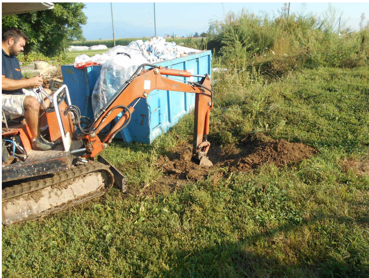
Figura 3: Scavo del pozzetto P1
