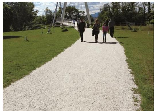
*Esempio di pavimentazione stradale in calcestre in progetto.*
