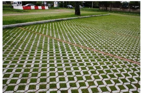
*Esempio di pavimentazione con autobloccanti drenante in progetto.*
