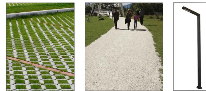
ESEMPIO DI PARCHEGGI IN AUTOBLOCCANTI DRENANTI / ESEMPIO DI PAVIMENTAZIONE IN CALCESTRE / IPOTESI ILLUMINAZIONE PARCHEGGIO
